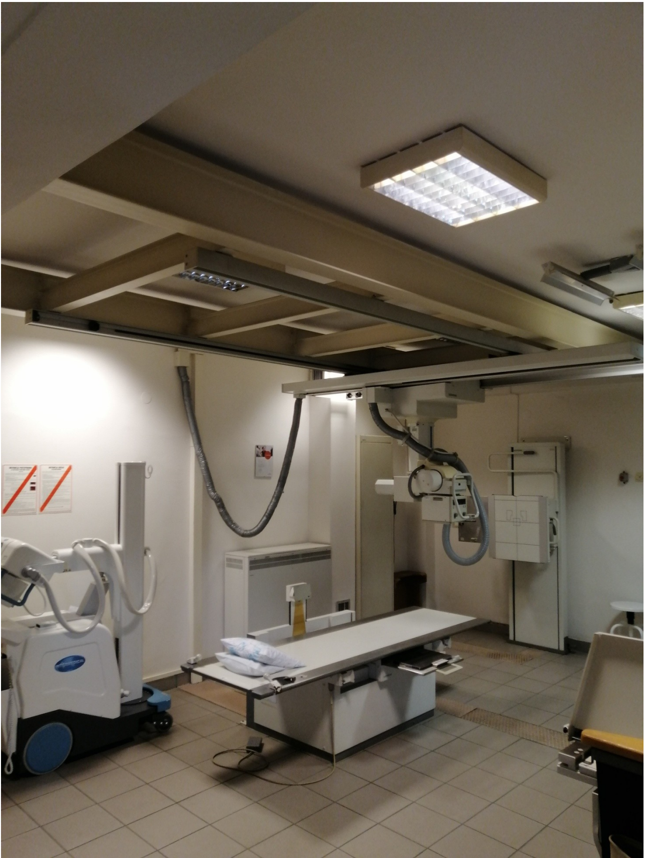
Aparat RTG do demontažu
